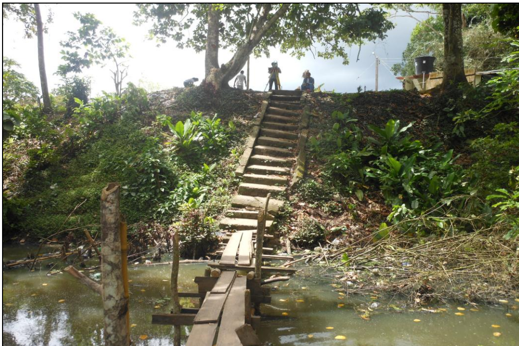
Figura 49 Talud a la altura de la calle 5.
