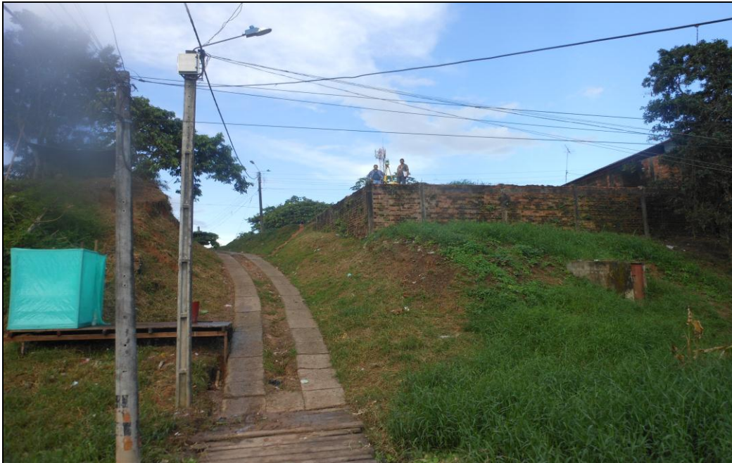
Figura 48 Talud a la altura de la calle 4.
