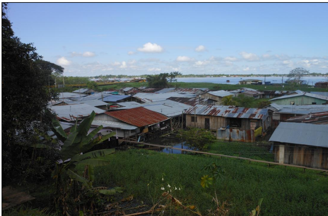
Figura 50 Talud a la altura de la calle 9. Biblioteca Banco de la República.
