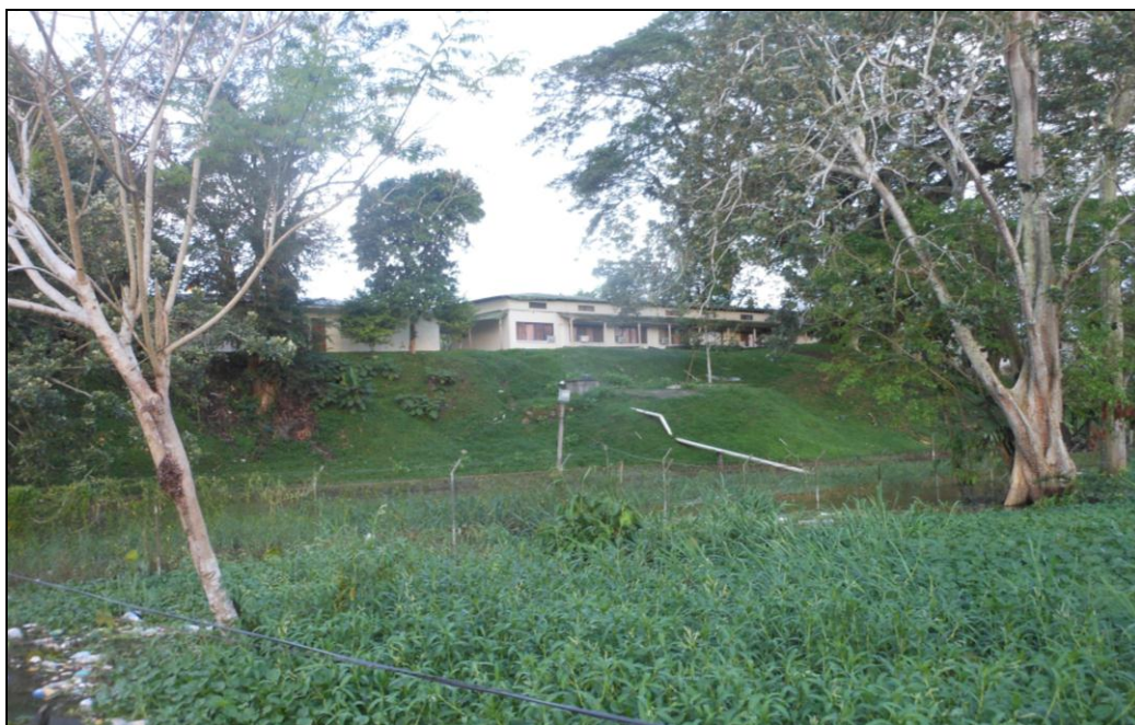
Figura 51 Talud a la altura de la calle 15. Club de Sub-oficiales.
