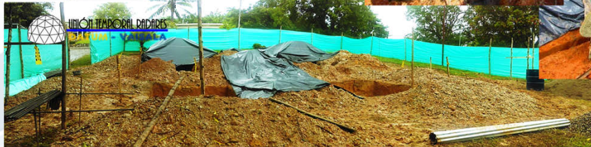
OBRA: RADAR METEOROLÓGICO BARRANCABERMEJA
