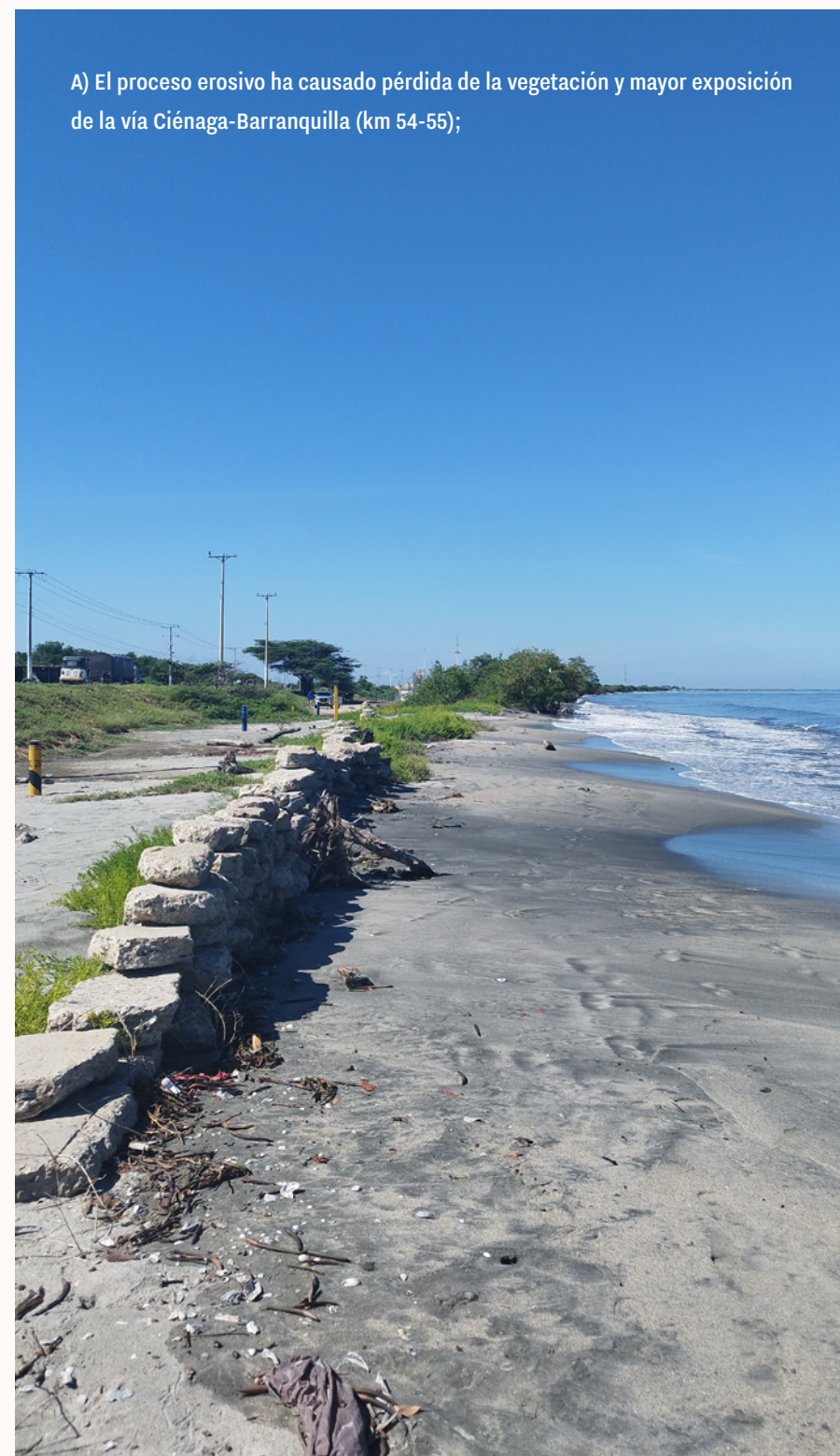
Figura 29. Estado de la playa por el retroceso de la línea de costa
