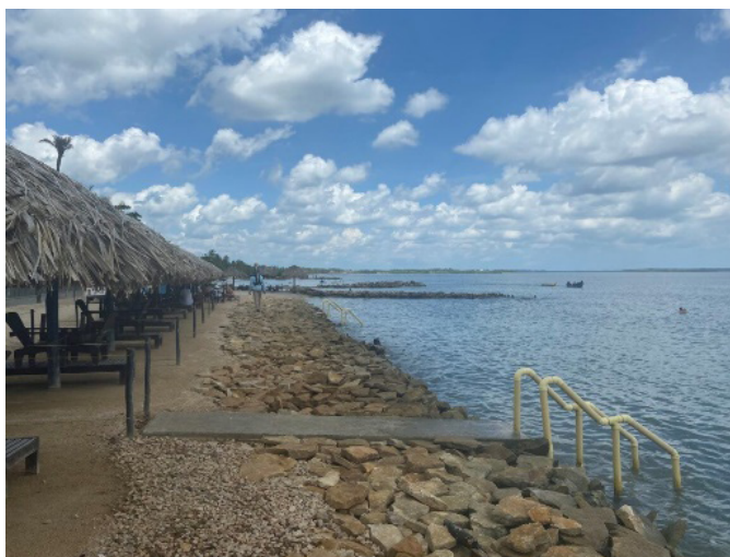
Figura 2.141. Obras duras sobre la línea de costa en Playa Blanca
