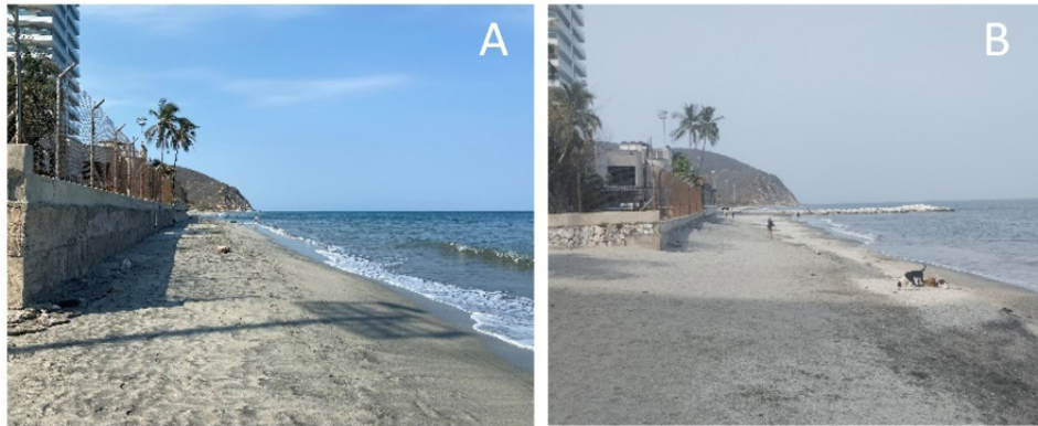
Figura 2.136. Estado de recuperación del perfil de playa en el punto entre la calle 27 y 28 de Playa Salguero
