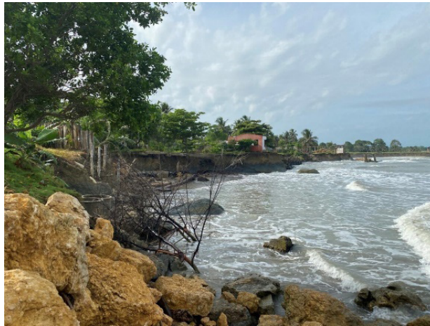
Figura 2.139. Procesos de erosión en la costa de Puerto Rey favorecido por la presencia de rocas sedimentarias fracturadas en acantilados
